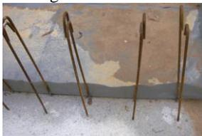
Verwenden Sie für die Erstellung der Stützwände Montagewandsteine oder Betonsteine mit 24 cm Breite. Stoßen Sie Armierstäbe (10mm) von oben durch die Öffnungen der Mauersteine und verbinden Sie diese mit den Armierungseisen aus der Bodenplatte. Gießen Sie sämtliche Öffnungen mit Beton aus.
