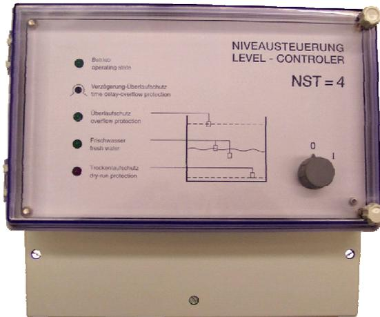
Diese universell einsetzbare Niveausteuering ist für alle flüssigen Medien geeignet, die über eine ausreichende Leitfähigkeit verfügen, also nicht für destilliertes Wasser oder für solche Medien, die in die Kategorie "explosionsgefährdet" einzustufen sind.
